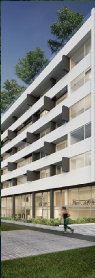
EDIFICIO ALBORA Santiago Centro
